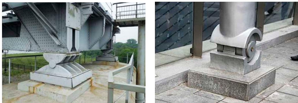
Рис. 2.1.2. Шарнирные опоры
