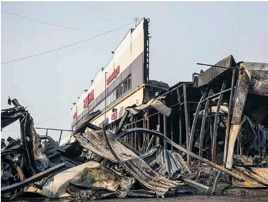
Рис. 10.1.1 Последствия пожара в ТЦ «Адмирал», г. Казань, 2015 г.
