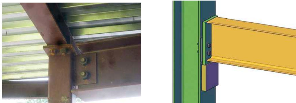
Рис. 2.1.3. Шарнирные узлы с податливыми элементами
