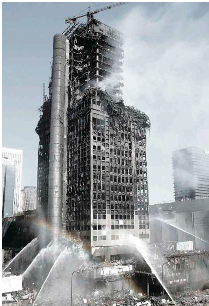
Рис. 10.3.1. Здание «WindsorTower's» в Мадриде после пожара (Фото с сайта www.elnortedecastilla.es )
