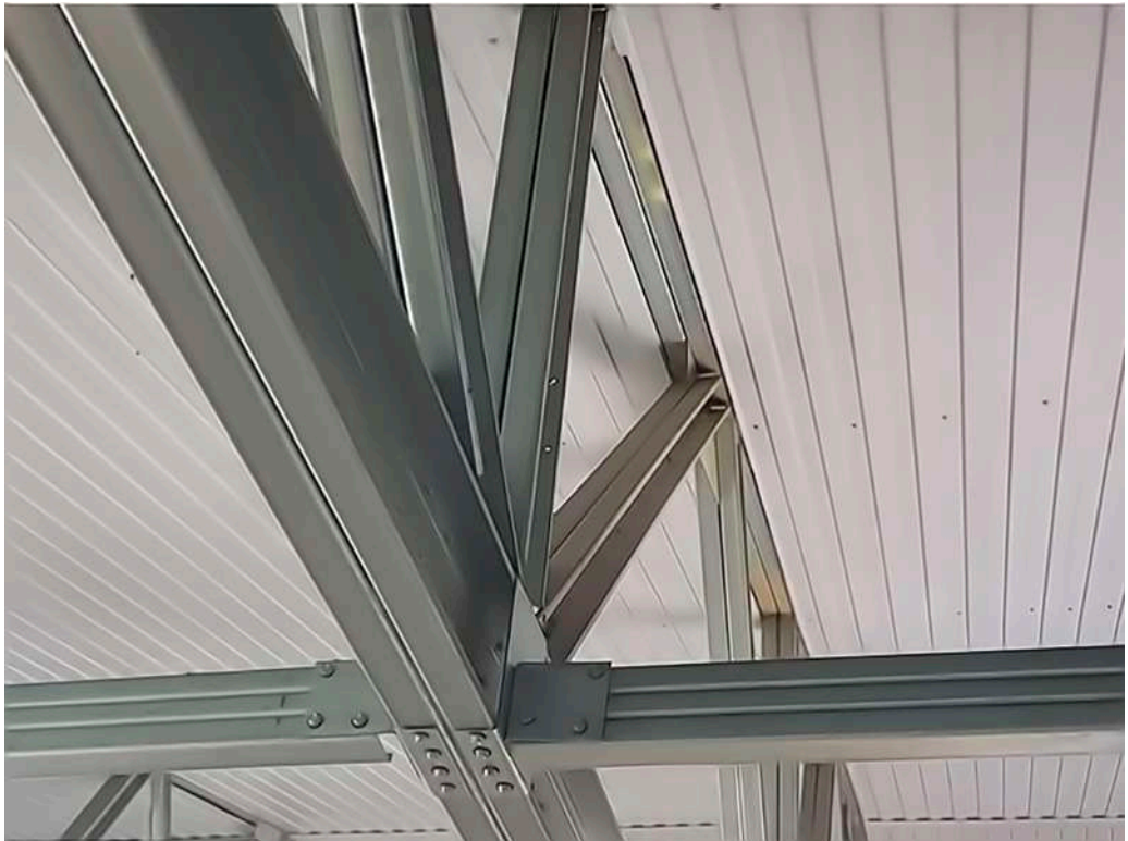
Рис. 8.3.1. Ферма на основе ЛСТК (пролетом 24 м)
