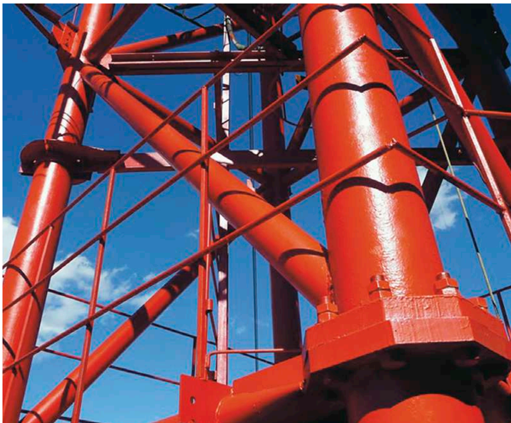
Рис. 1.6.8. Пример металлоконструкции с использованием труб большого диаметра
