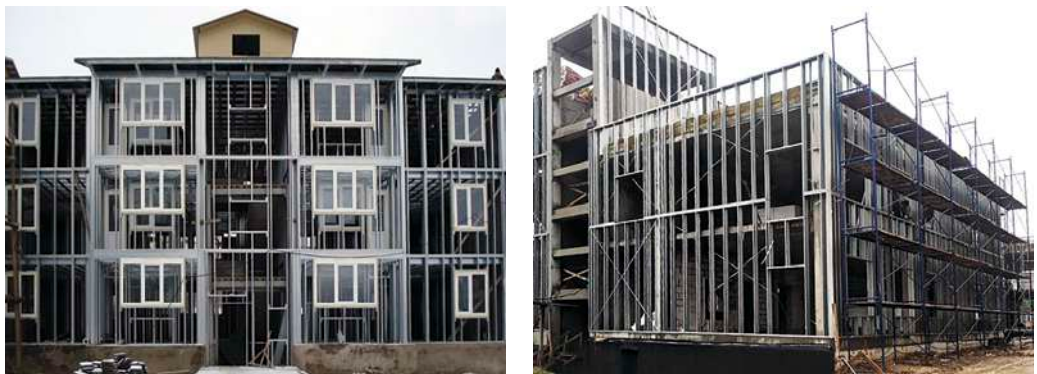
Рис. 8.3.11. Несущие и ненесущие КОС в каркасных зданиях:
