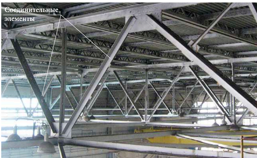
Рис. 5.3.3. Соединительные элементы в фермах из парных уголков
