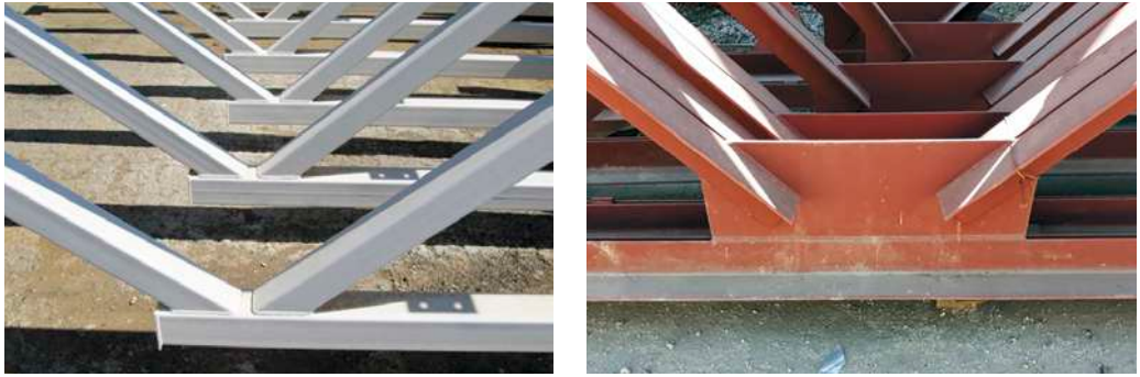
Рис. 2.1.4. Узлы ферм
