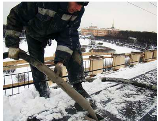
Рис. 8.4.3. Подача насосом пенобетонной смеси в заполняемое пространство
